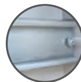
Trilho de fixação DIN.
